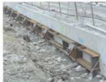
Esecuzione dei tiranti di tipo attivo a sette tralci per vincolare in simmetria la paratia di pali secanti Execution of the active seven-threads rods to fix the top of the wall to the secant piles
