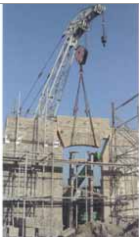
Prelievo dei singoli blocchi murari e degli architravi Removal of the blocks and of the architraves
