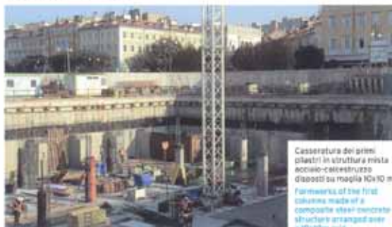
Realizzazione della piastra di fondazione di calcestruzzo armato, ancorata su micropilati per il contenimento della sottopinta idraulica Execution of the reinforced concrete foundation slab connected to micro piles to contain the hydraulic pressure underneath
