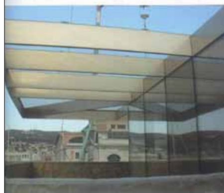
Completamento della pensilina vetrata, copertura dell'intercapedine tra l'involucro interno e i muri originali esterni. Completion of the glazed canopy, cover of the gap between the internal envelope and the original external walls.
