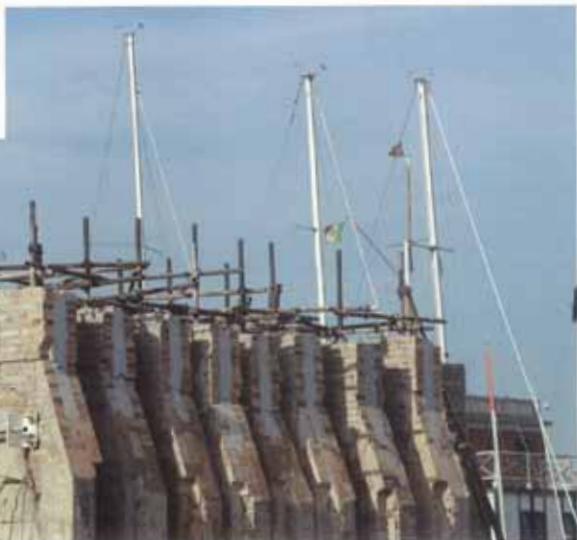
Accantonamento dei singoli conci murari, opportunamente catalogati, in un'area limitrofa al cantiere Stacking of the individual blocks, appropriately catalogued in an area close to the site
