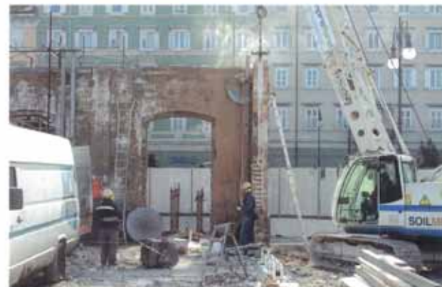
Taglio del primo massiccio murario: dettaglio della lama movimentata su binari metallici. Cut of the first wall block: detail of the blade moving on metal tracks.
