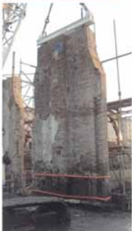
Prelievo dei singoli blocchi murari e degli architravi Removal of the blocks and of the architraves
