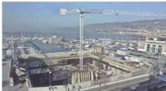
Realizzazione della piastra di fondazione di calcestruzzo armato, ancorata su micropilati per il contenimento della sottopinta idraulica Execution of the reinforced concrete foundation slab connected to micro piles to contain the hydraulic pressure underneath
