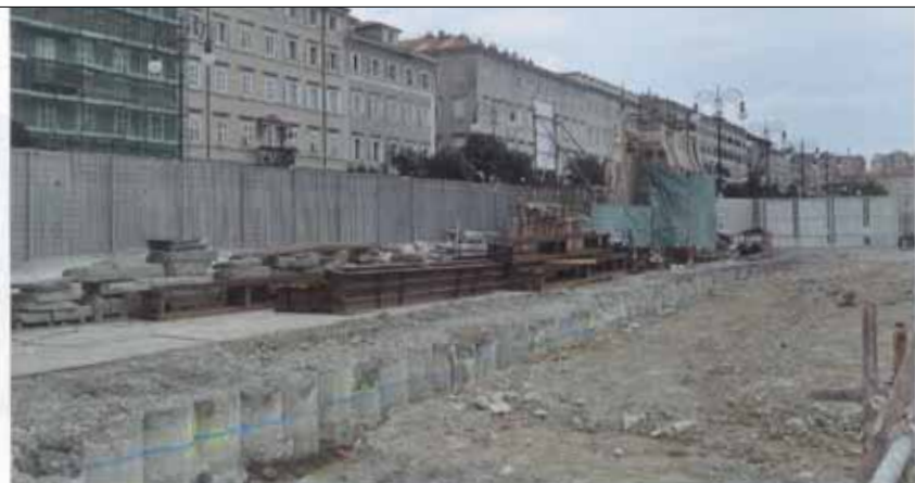
Esecuzione dei pali secanti, armati sul substrato roccioso, per il contenimento del terreno Execution of the secant piles, connected onto the level of rock to retain the ground
