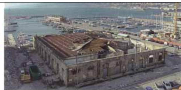
Stato di fatto: il manufatto ottocentesco progettato dall'Ufficio Tecnico Marino è successivamente aditato all'impiego come deposito del vino. Old concrete the 19th century building designed by the Marine Technical department and subsequently used as a wine cellar.
