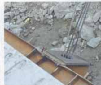
Esecuzione dei tiranti di tipo attivo a sette tralci per vincolare in simmetria la paratia di pali secanti Execution of the active seven-threads rods to fix the top of the wall to the secant piles
