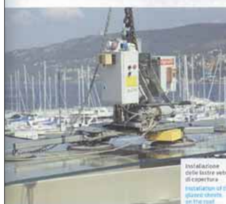
Il belvedere è realizzato mediante una lastra unica in traliccio: vetro (12x12x12 mm), lunga circa 9 m. L'installazione, avvenuta dal mare, ha richiesto un sistema di ventose appostamente studiato.
