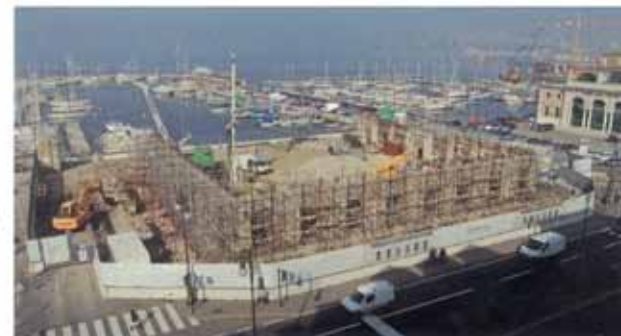
Demolizione del manufatto preesistente sul sito e del muro perimetrale ancorato al mare, con messa in sicurezza delle restanti murature. Demolition of the existing buildings on the site and of the perimeter wall overturning the sea with the temporary works for the remaining walls.
