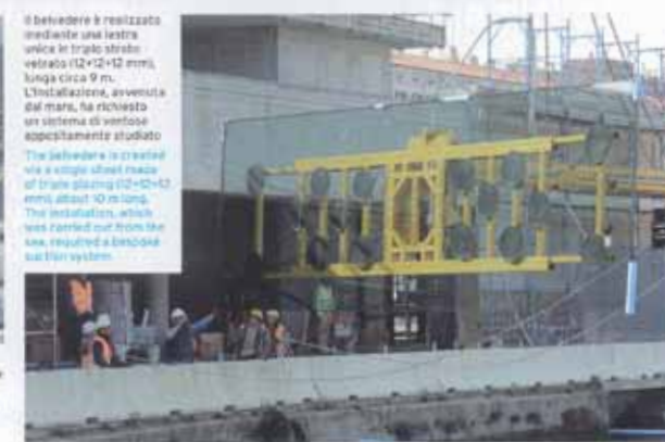
Installazione delle lastre vetrate di copertura. Installation of the glass sheets on the roof.
