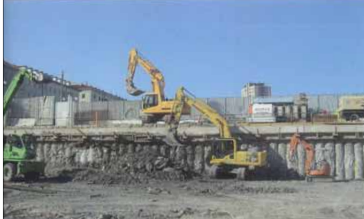
Scavo di sbiancamento per il raggiungimento della quota del secondo livello interrato Excavation works to reach the second basement level's depth
