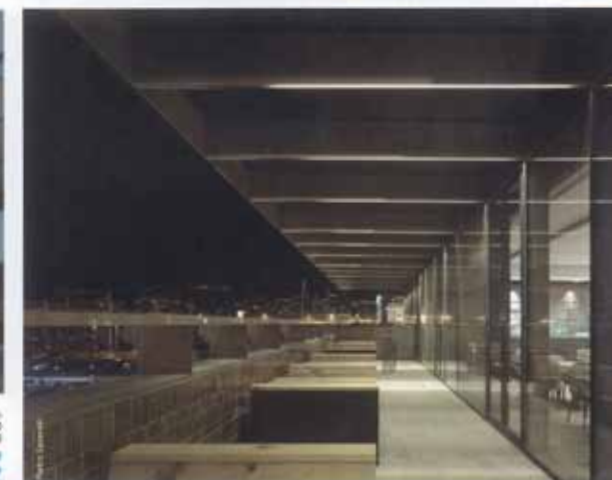
Completamento della pensilina vetrata, copertura dell'intercapedine tra l'involucro interno e i muri originali esterni. Completion of the glazed canopy, cover of the gap between the internal envelope and the original external walls.
