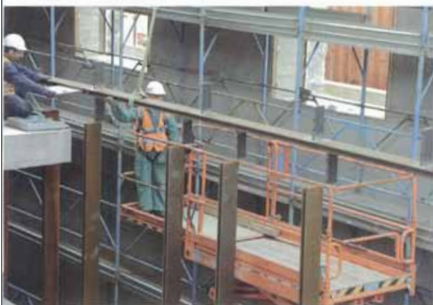
Montaggio delle carpenterie metalliche e del sistema in montanti e travetti per la realizzazione dell'involucro vetrato. Installation of the metal carpentry and of the frame and subframe system for the creation of the new glazed envelope.
