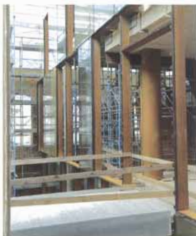
Montaggio delle carpenterie metalliche e del sistema in montanti e travetti per la realizzazione dell'involucro vetrato. Installation of the metal carpentry and of the frame and subframe system for the creation of the new glazed envelope.
