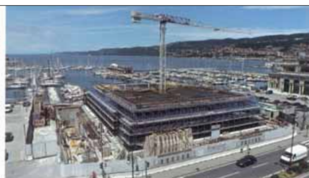
Esecuzione dei sovrapposti di calcestruzzo armato Execution of the reinforced concrete floors
