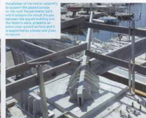
Realizzazione delle carpenterie metalliche di sostegno della pensilina vetrata in copertura: la parte perimetrale, che chiude lo spazio di circa 3 m tra l'edificio vetrato e i muri storici, presenta una superficie vetrata estrachiusa ed è sorretta da una struttura di ottone brunito e vetro.
