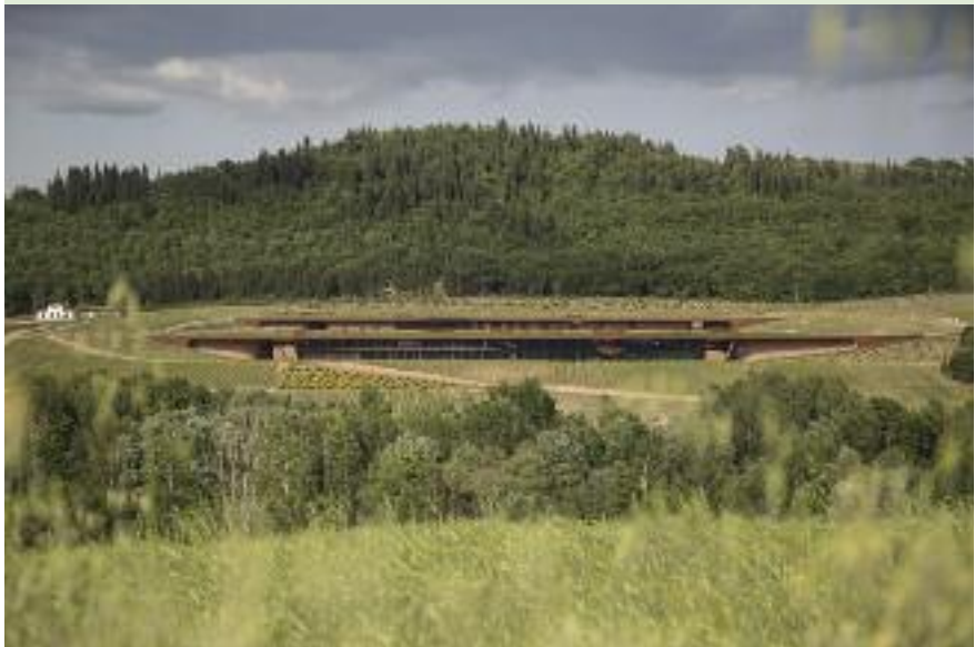
Cantina Antinori nel Chianti. Progetto di M.Casamonti Archea (foto di Pietro Savorelli).
